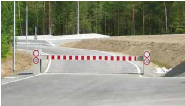
Abbildung 7-16: Versenkbare Durchfahrtsperre (BLS, „Barrier Lift System“)
