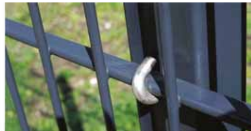
Abbildung 7-7: Stabgitterzaun mit horizontalem Flachstahlprofil als Endloszaun mit variablen Pfostenabständen
