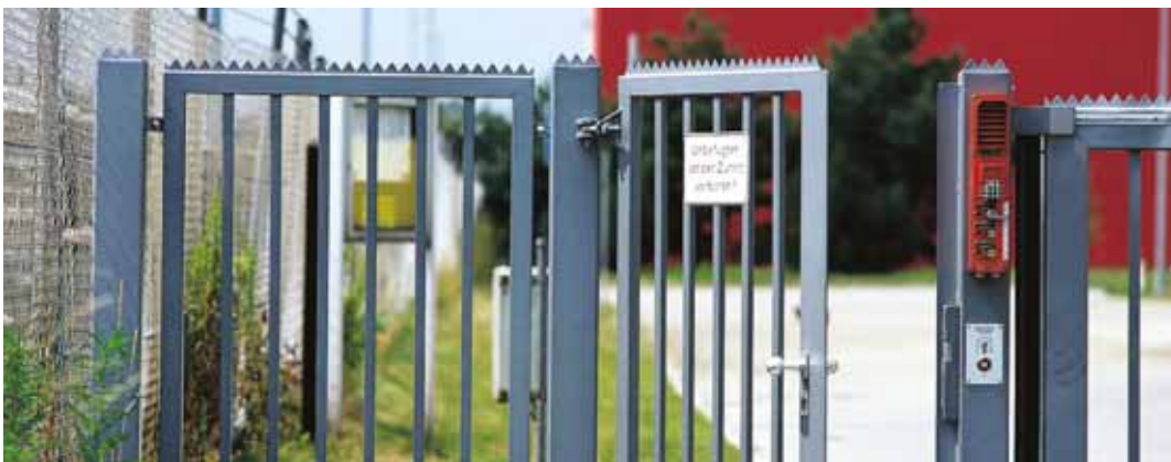
Abbildung 7-14: Übersteigenschutz in Form von Zackenleisten
