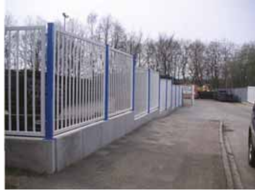
Abbildung 7-9: Frontgitterzaun mit Bodenplatten
