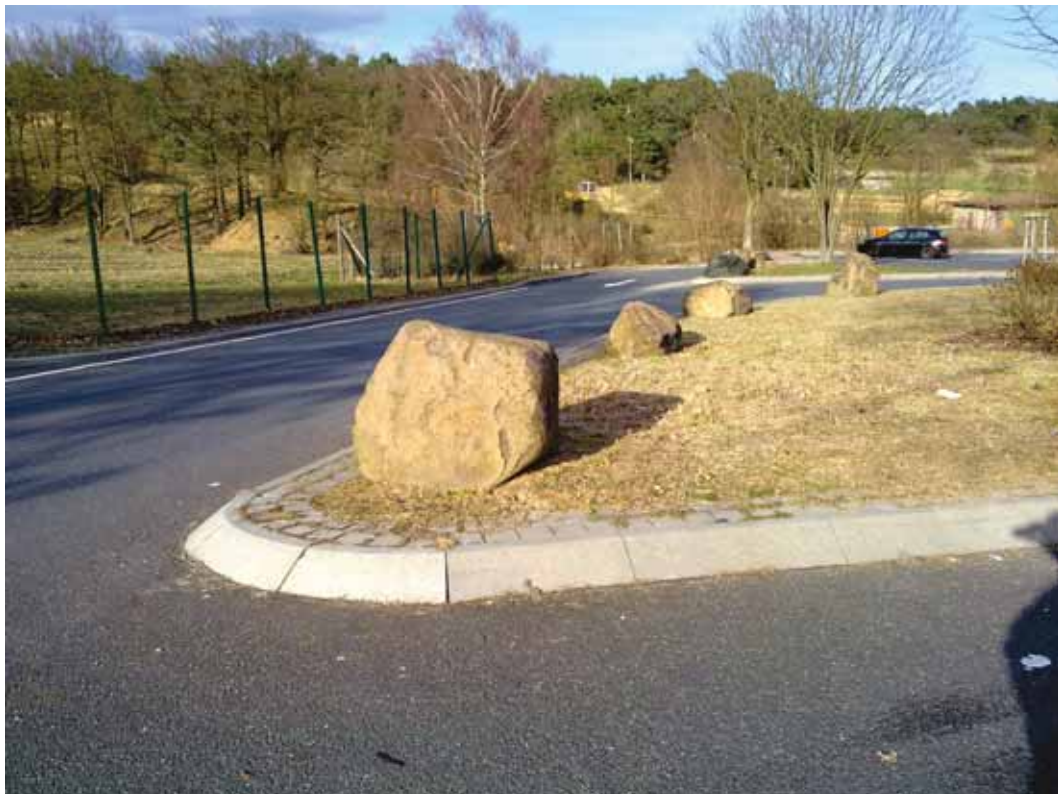
Abbildung 7-2: Durch kurvige Führung des Zufahrtsweges kann verhindert werden, dass ein angreifendes Kraftfahrzeug eine kritische Geschwindigkeit erreicht.
