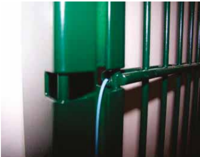
Abbildung 8-2: Detektionszaun mit eingezogenem Alarmdraht
