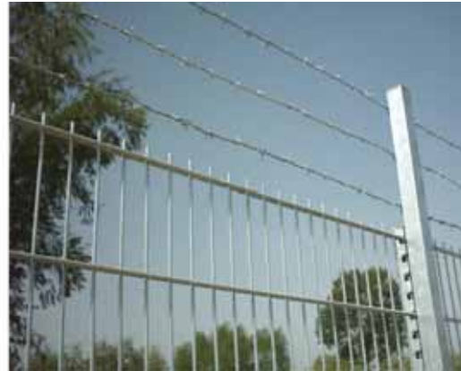
Abbildung 7-13: Klassischer Stacheldraht in Verlängerung des Gittermattenzauns
