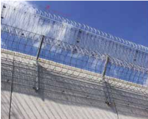
Abbildung 7-12: S-Draht, gerollt mit Ziehharmonikaeffekt (Sperrdraht)
