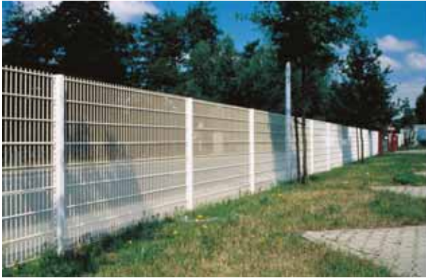
Abbildung 7-4: Stabgitterzaunanlage
