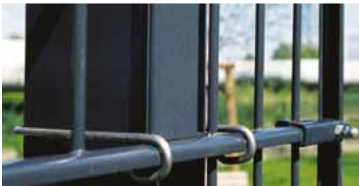
Abbildung 7-6: Stabgitterzaun mit horizontalem U-Profil als Endloszaun mit variablen Pfostenabständen
